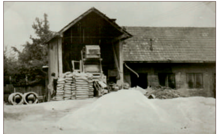
KOMUNÁLNE SLUŽBY - BETONÁRSKA VÝROBA NA HOLLÉHO UL.
